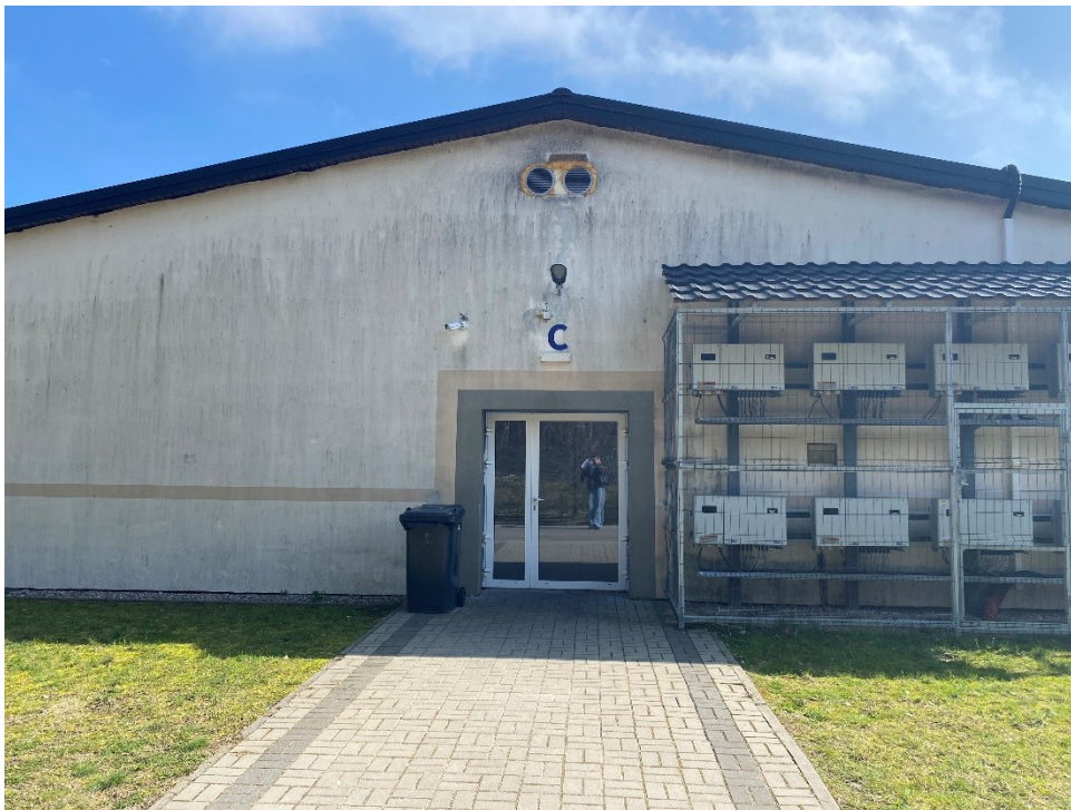
Rysunek 6 Lokalizacja inwestycji – elewacja zachodnia budynku C
