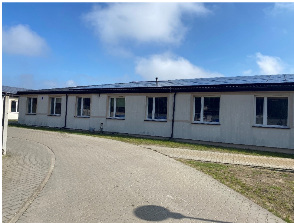
Rysunek 5 Lokalizacja inwestycji – elewacja zachodnia budynku B
