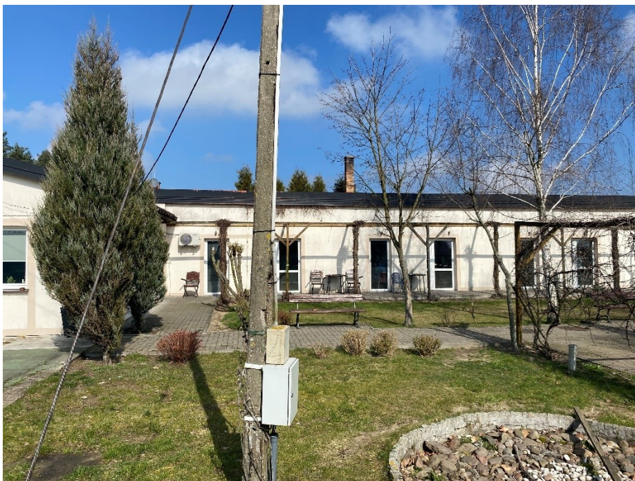
Rysunek 3 Lokalizacja inwestycji – elewacja południowa budynku A
