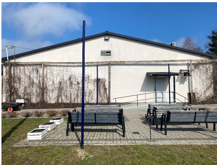
Rysunek 14 Lokalizacja inwestycji – elewacja południowa budynku G
