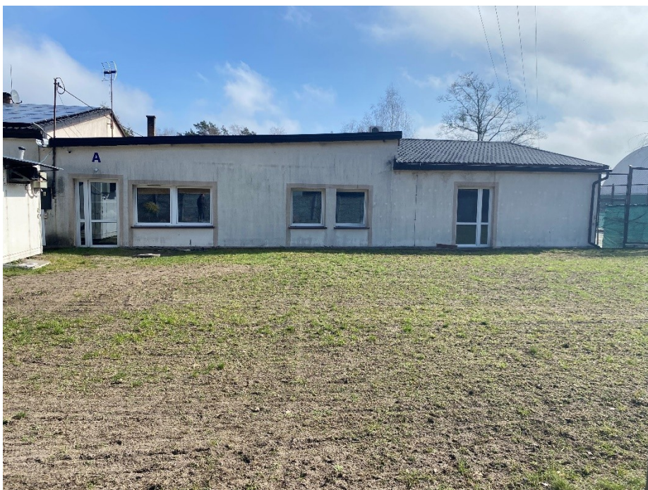
Rysunek 4 Lokalizacja inwestycji – elewacja zachodnia budynku A
