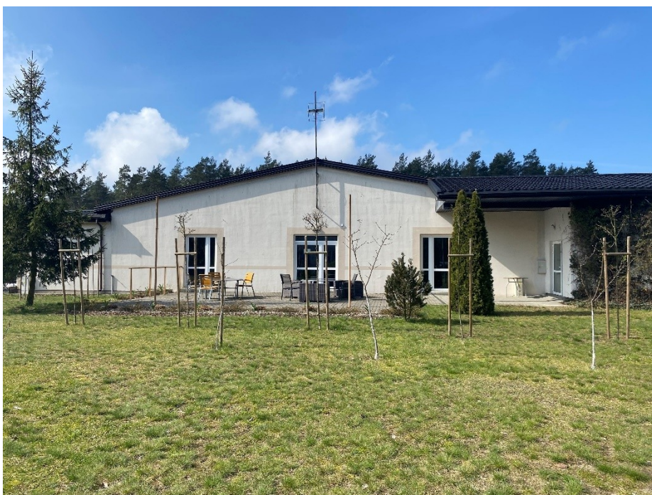
Rysunek 13 Lokalizacja inwestycji – elewacja wschodnia budynku E
